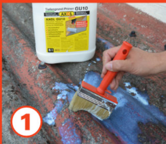
1 Dachfläche grundieren
