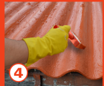
4 Übergänge doppelt streichen
