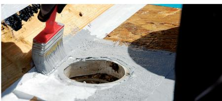
Tragen Sie die erste Schicht **Alfa proteXos ETAG-SEAL** auf. Legen Sie nun blasenfrei Ihre Vlieszuschnitte in die noch nasse erste Schicht. Arbeiten Sie das Vlies in den Dichtstoff ein. Anschließend erfolgt nach dem Prinzip frisch-in-frisch die 2. Schicht **Alfa proteXos ETAG-SEAL** (**Achtung: bei frisch-in-frisch Auftrag ist die Verwendung von Alfa proteXos DRYING TURBO notwendig!**).
