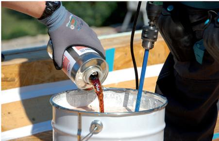
Achten Sie dabei darauf, keine Luftblasen mit einzurühren. Für schnellere Trocknungszeiten und zur Erhöhung der Viskosität bei vertikalen Anwendungen oder um eine 25-Jahre-Systemgewährleistung (W3) zu erreichen, fügen Sie **Alfa proteXos DRYING TURBO** hinzu und rühren Sie gründlich um. Für die nass-in-nass Verarbeitung ist der **Alfa proteXos DRYING TURBO** obligatorisch.
