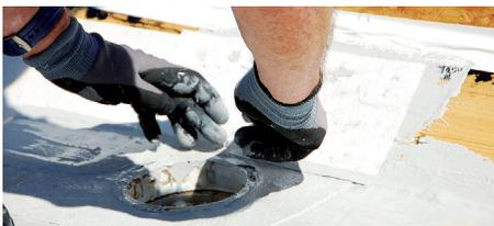
Um ein sauberes Ergebnis zu erhalten, kleben Sie den Detailanschluss auf dem Untergrund quadratisch ab. Begrenzen Sie auch die Höhe des Detailanschlusses. Gemäß Flachdachrichtlinien in einer Höhe von 15cm.
