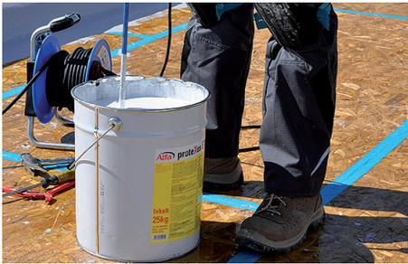
Anwendungstemperatur (Umgebung) zwischen +5 °C und +40 °C. Maximale Umgebungsfeuchtigkeit 85 %. Während der Verarbeitung sollte die Temperatur beständig sein oder abnehmen. Im Sommer nicht während der heißesten Zeit des Tages anwenden.
