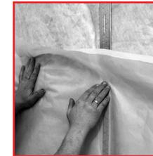
Folie ausrichten und kräftig anreiben. Einfache und sichere Montage ohne Beschädigung der Folie durch Tackern.
