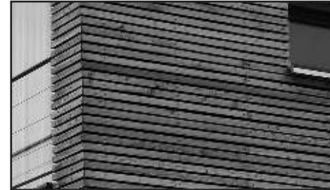
154 Alfa UV-Black eignet sich für die unsichtbare winddichte Verklebung von Schalungsbahnen z.B. hinter Holzfassaden.
