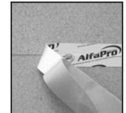
Bei der Fugenabdichtung von Span-/OSB-Platten wird **AlfaPro 161** mittels Hart-gummiroller vollflächig kräftig angerieben. Dies erhöht die Anfangsklebkraft.
