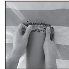
Bei runden Durchdringungen, wird **AlfaFlex 153** in kleinen Streifen schuppenartig luftdicht verklebt.
