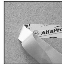
Bei der Fugenabdichtung von Span-/OSB-Platten wird **161 Alfa Pro** mittels Hart-gummiroller vollflächig kräftig angerieben. Dies erhöht die Anfangsklebkraft.
