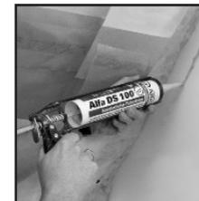
**Alfa DS 100 Folienkleber** direkt und ohne Primer auf den Untergrund auftragen. Anschließend Folie leicht andrücken (Kleber hierbei nicht verpressen).
