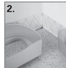
2. Bei Innen-/Außenecken mit einem Fön die Rückseite der Sockelleiste erwärmen und entsprechend verformen. Dann zug- und spannungsfrei montieren und anschlagen.
