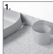
1. Alfa Rubtac50 wird auf die Wand aufgetragen und kräftig angerieben. Silikonpapier von Alfa Rubtac50 abziehen, Kautschuk-Sockelleiste anpassen, andrücken und anschlagen (verstärkt die Klebkraft).
