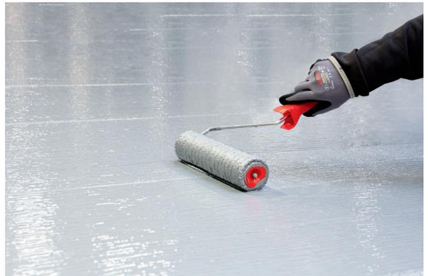
Achten Sie darauf, die Verbrauchsangaben einzuhalten. Bei Überdosierung entstehen in der Endbeschichtung Blasen sowie ein Ablösen der Deckschicht kann möglich sein.
