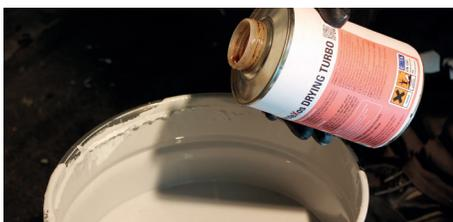
Soll die Trocknungszeit beschleunigt werden bzw. soll das Dach gemäß W3 abgedichtet werden, fügen Sie die jeweilige Menge **Alfa® proteXos DRYING TURBO** hinzu.
