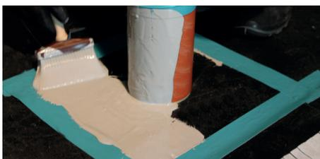
Um ein sauberes Ergebnis zu erhalten, kleben Sie den Detailanschluss auf dem Untergrund quadratisch ab. Begrenzen Sie auch die Höhe des Detailanschlusses. Gemäß Flachdachrichtlinien in einer Höhe von 15cm.
