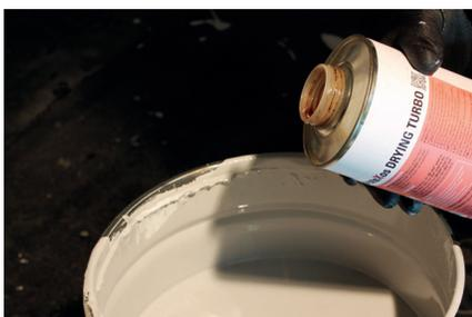
Achten Sie dabei darauf, keine Luftblasen mit einzurühren. Für schnellere Trocknungszeiten und zur Erhöhung der Viskosität bei vertikalen Anwendungen oder um eine 25-Jahre-Systemgewährleistung (W3) zu erreichen, fügen Sie **Alfa® proteXos DRYING TURBO** hinzu und rühren Sie gründlich um.
