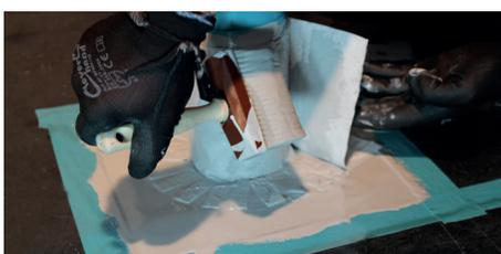
Tragen Sie die erste Schicht **Alfa® proteXos ETAG-SEAL** auf. Legen Sie nun blasenfrei Ihre Vlieszuschnitte in die noch nasse erste Schicht. Arbeiten Sie das Vlies in den Dichtstoff ein. Anschließend erfolgt nach dem Prinzip frisch-in-frisch die 2. Schicht **Alfa® proteXos ETAG-SEAL**. Optional kann die erste Schicht auch erst trocknen bevor die zweite Schicht aufgetragen wird.
