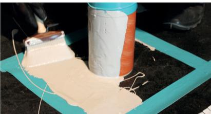
Um ein sauberes Ergebnis zu erhalten kleben Sie den Detailanschluss auf dem Untergrund quadratisch ab. Begrenzen Sie auch die Höhe des Detailanschlusses. Gemäß Flachdachrichtlinien in einer Höhe von 15cm.
