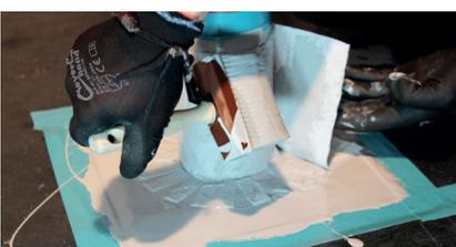
Tragen Sie die erste Schicht **Alfa® proteXos ETAG-SEAL** auf. Legen Sie nun blasenfrei Ihre Vlieszuschnitte in die noch nasse erste Schicht. Arbeiten Sie das Vlies in den Dichtstoff ein. Anschließend erfolgt nach dem Prinzip frisch-in-frisch die 2. Schicht **Alfa® proteXos ETAG-SEAL**. Optional kann die erste Schicht auch erst trocknen bevor die zweite Schicht aufgetragen wird.
